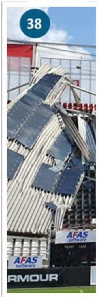
Vervorming uit het vlak van vakwerkligger 38
